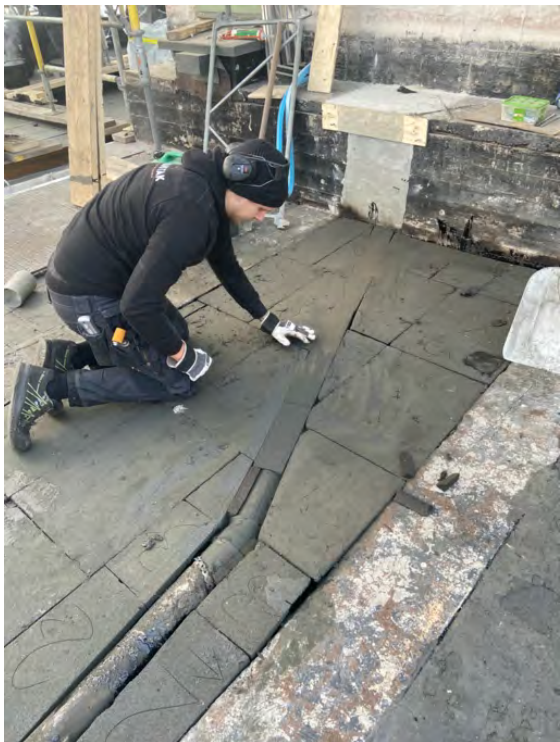
Ovan till vänster: Här monteras cellglasskivor (90A). De ger huset bättre energiprestanda och isolerar mot ljud från terrassen ner till lägenheterna under. Till höger: De nya dagvattenbrunnarna monteras och förberedes för tätskiktet. Ovanpå cellglaset kommer tätskiktet att läggas och sedan gjuts cirka 15 cm armerad slitbetong.
