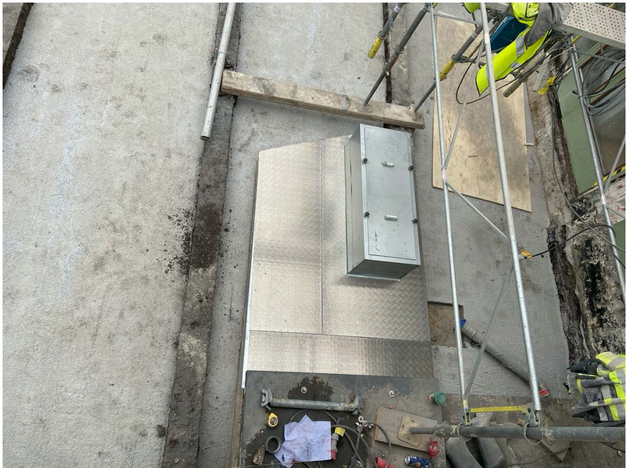
Ventilationskanalerna tätas med ny plåt innan de gjuts igen.
