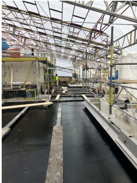
Efter cellbetongen läggs en tunn asfaltsprimer som gör att cellglaset kan klistras fast.
