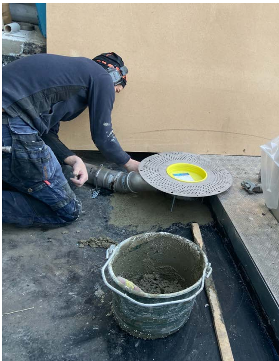
Ovan till vänster: Här monteras cellglasskivor (90A). De ger huset bättre energiprestanda och isolerar mot ljud från terrassen ner till lägenheterna under. Till höger: De nya dagvattenbrunnarna monteras och förberedes för tätskiktet. Ovanpå cellglaset kommer tätskiktet att läggas och sedan gjuts cirka 15 cm armerad slitbetong.
