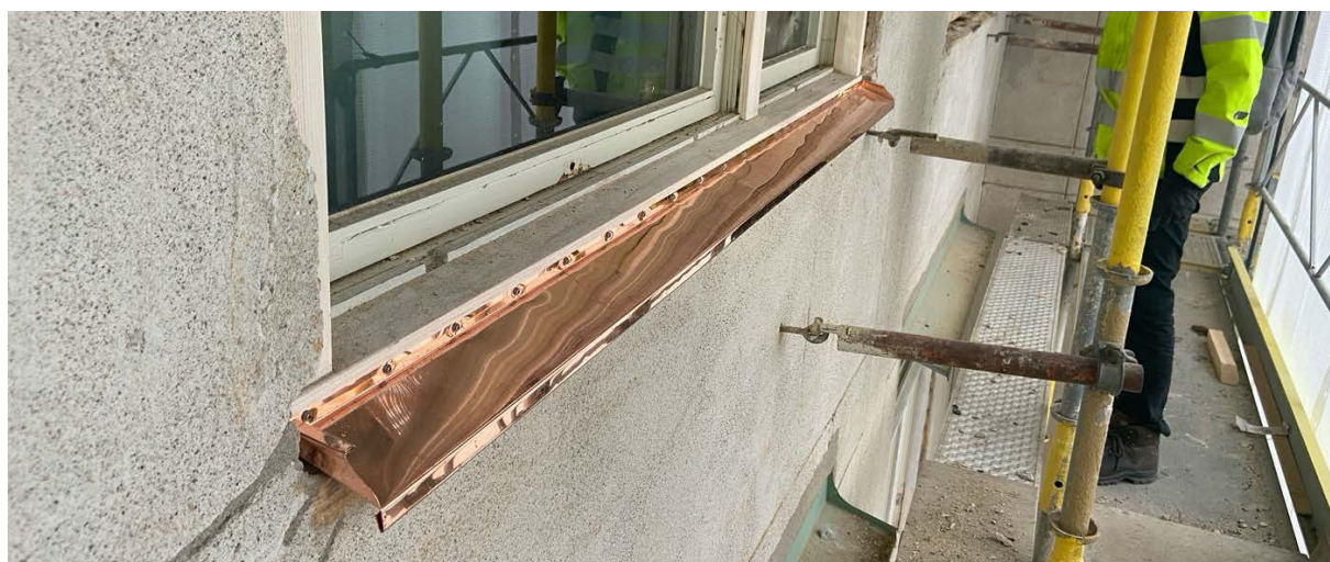
Nya fönsterbleck i koppar på gårdsfasaden (obs, fasaden ännu ej putsad)
