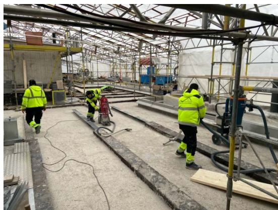
Till vänster: Terrassens nakna bjälklag efter att all fyllning är avlägsnad. Därefter har ett tunt lager cellbetong gjutits på.
