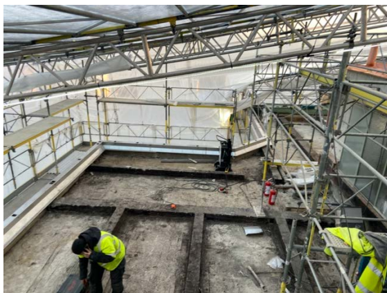
Till vänster: Terrassens nakna bjälklag efter att all fyllning är avlägsnad. Därefter har ett tunt lager cellbetong gjutits på.
